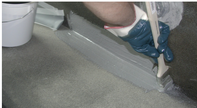
Påføring af Alfix Epoxy Membran
