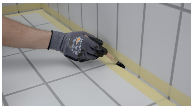
Efter montering af afdækningstape, påføres primer
