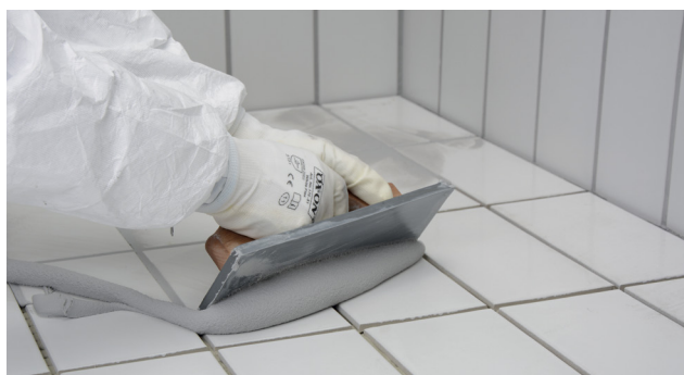
Påføring på gulv med epoxyfugebræt
