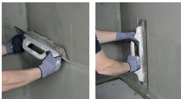
Påføring af 2K Tætningsmasse og glitning
