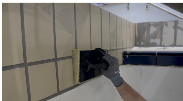
Fliserne afvaskes med hårdtopvredet viskosesvamp
