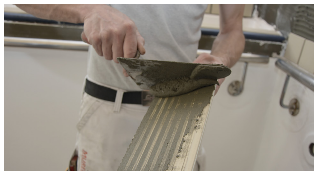
Påføring af skrabelag på flisens bagside
