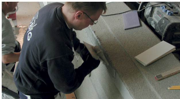
Påføring af Alfix C2 Epoxy med tandspartel
