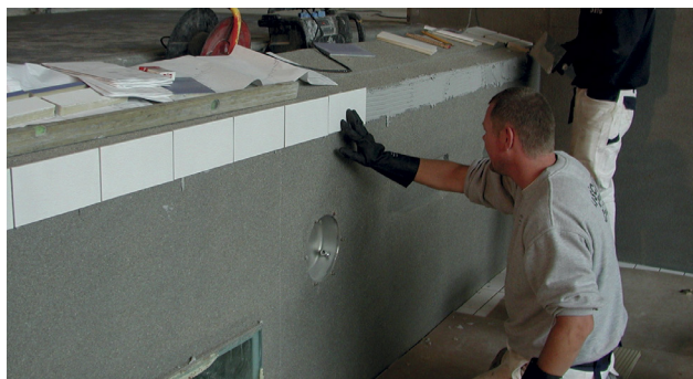
Montering af fliser i den fugtige klæber
