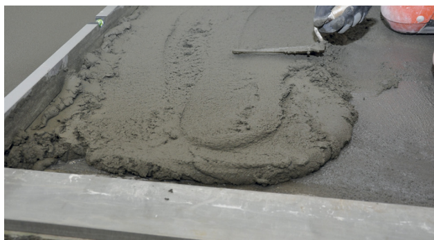
Udlægning og komprimering på gulv
