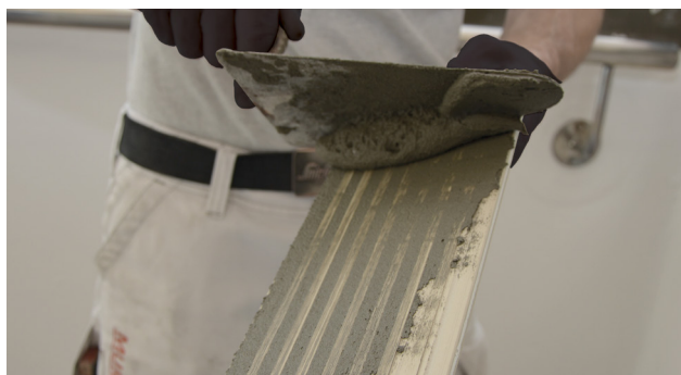
Påføring af skrabelag på flisens bagside
