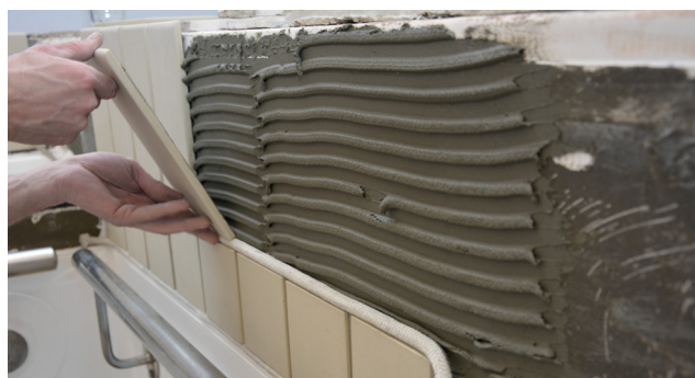
Montering af fliser
