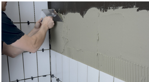
Påføring af fliseklæber med tandspartel
