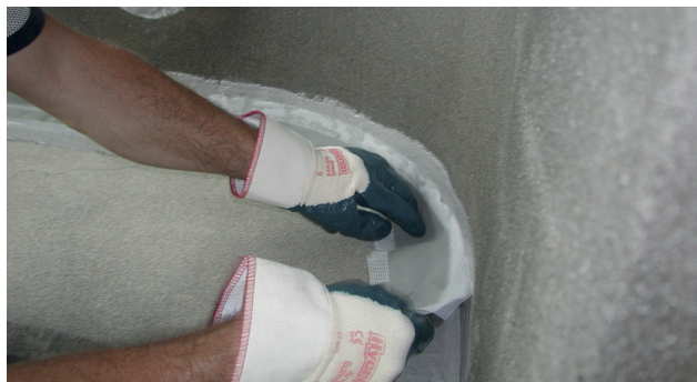
Montering af Alfix Tætningsbånd
