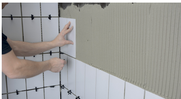
Montering af fliser
