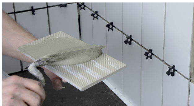
Påføring af skrabelag på flisens bagside
