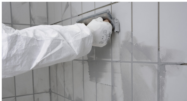
Påføring på væg med epoxyfugebræt
