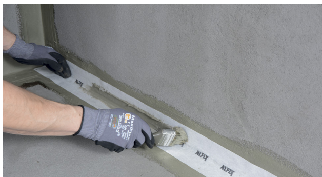
Montering af Alfix VT-tætningsbånd
