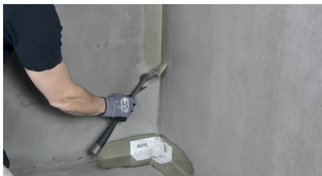
Montering af Alfix VT-hjørne i tætningsmasse
