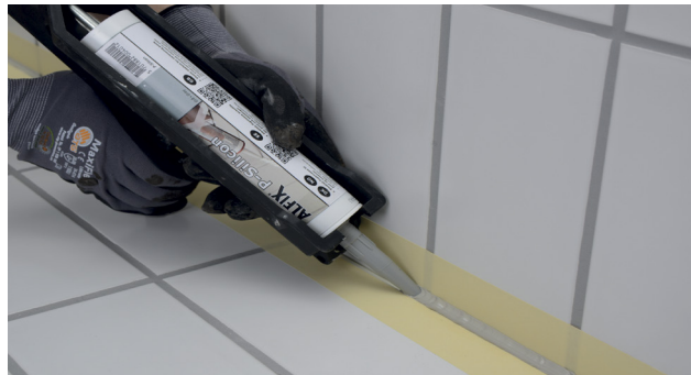
Når primeren er tør fyldes fugerne med Alfix M-Silicon
