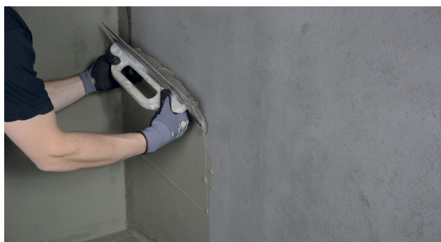
Påføring af Alfix 2K Tætningsmasse - porefyldende lag
