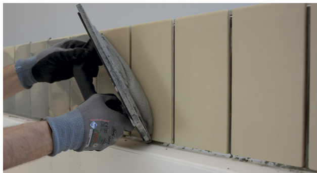
Påføring af Alfix IndustryFuge - CeraFill 18
