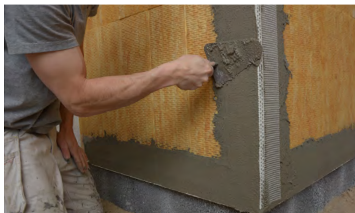
Hjørnelistens armeringsnet trykkes ind i grundpuds
