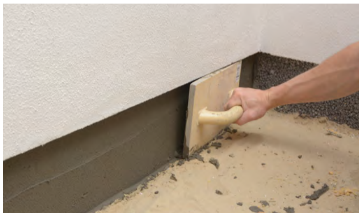
Bearbejdning med pudsebræt til jævn overflade
