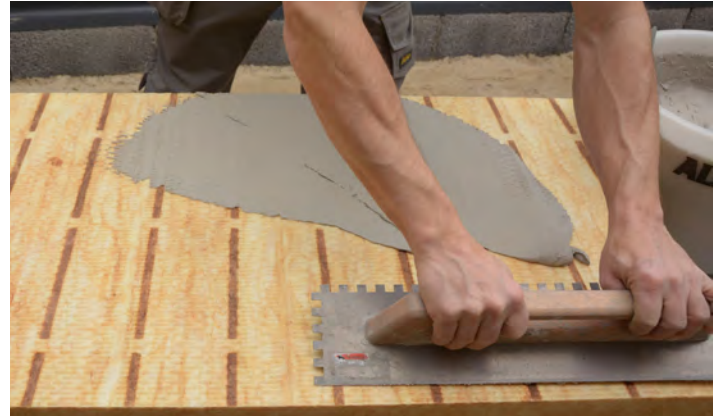
Påføring af facadeklæber med tandspartel
