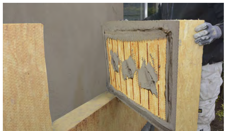
Montering på ujævnt underlag
