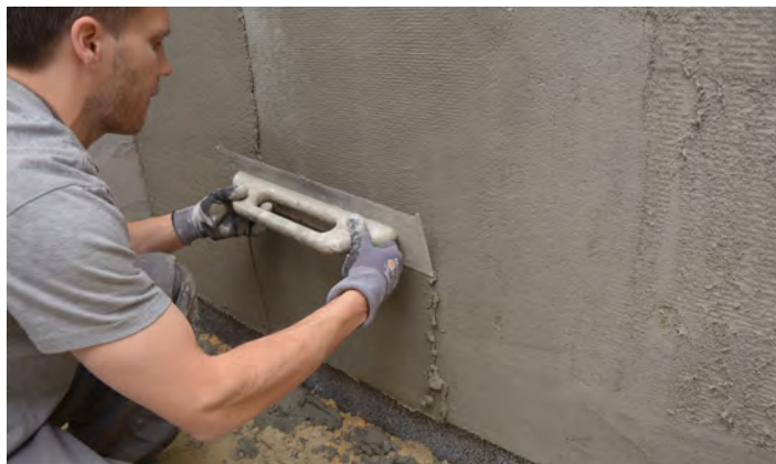
Påføring med stålbræt
