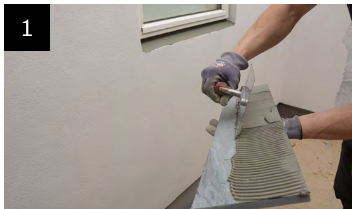
Påføring af klæber, Alfix ProFix, eller Alfix 2K Tætningsmasse
