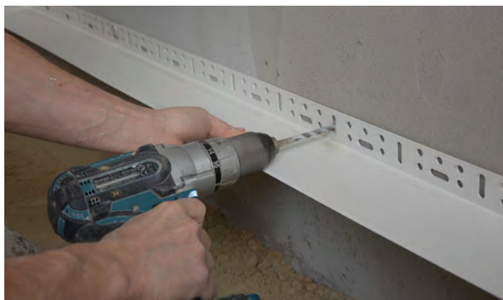
Forboring af hul til Alfix Startvinkel Flex
