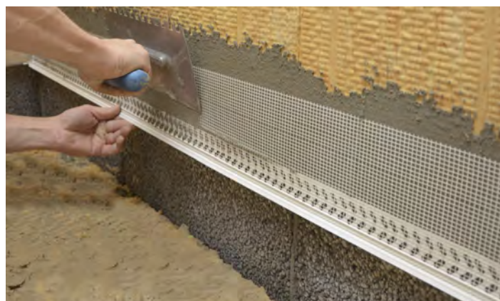
Bundlistens armeringsnet trykkes ind i grundpuds
