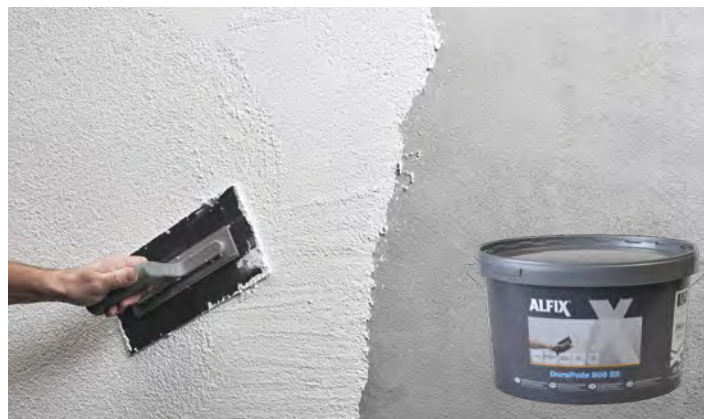
Overfladen bearbejdes med plast glittebræt
