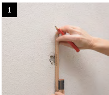
Markering af reparationsfelt
