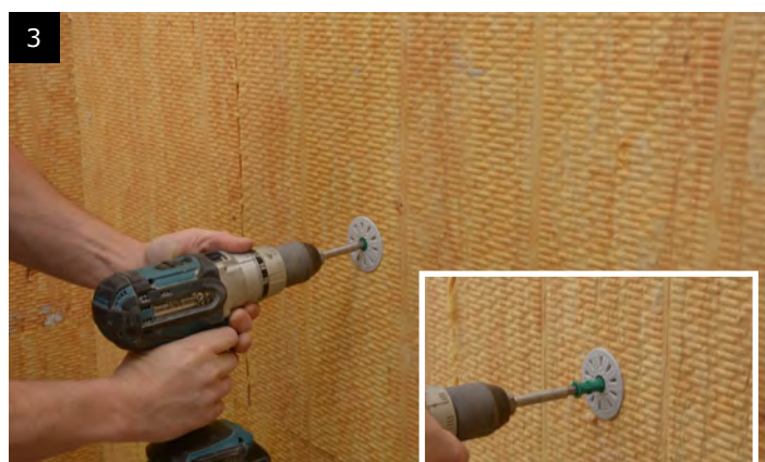
Montering af termodybel
