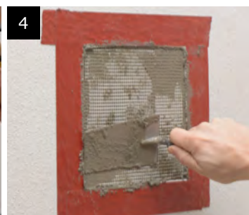
Grundpudslag og armeringsnet
