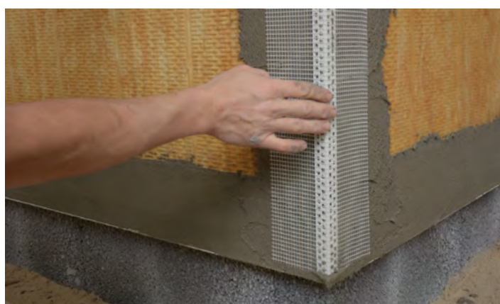
Placér hjørnelisten i den friskpåførte grundpuds
