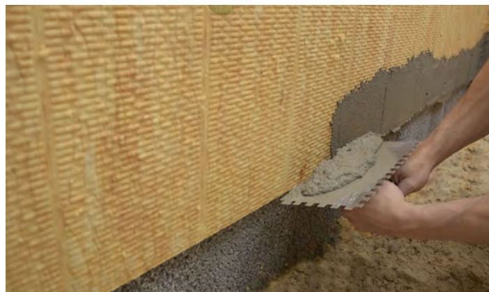
Påføring af grundpuds
