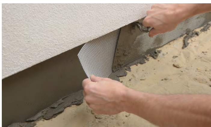
I den våde puds monteres armeringsnet
