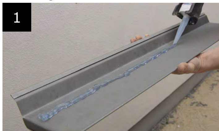
Påføring af Alfix M-Silicon
