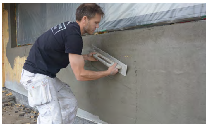
Træk grundpudsen på med stålbræt
