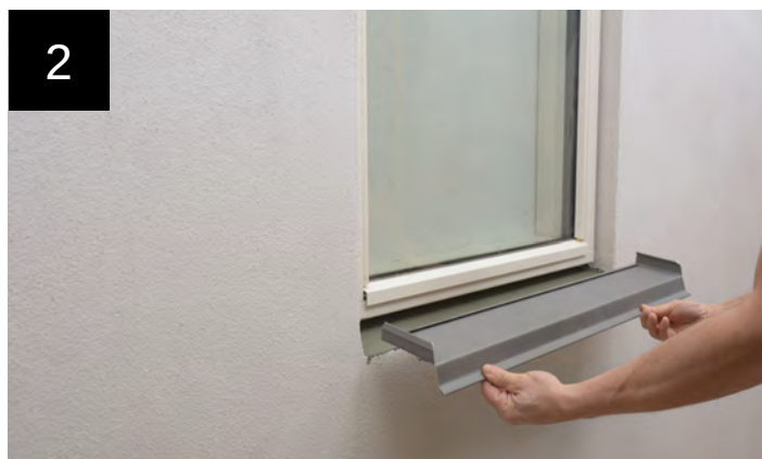
Montering af zink-inddækning
