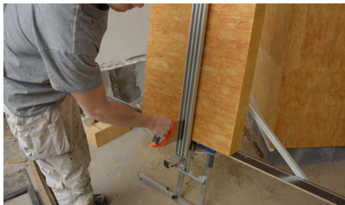
Tilskæring af isoleringsplade
