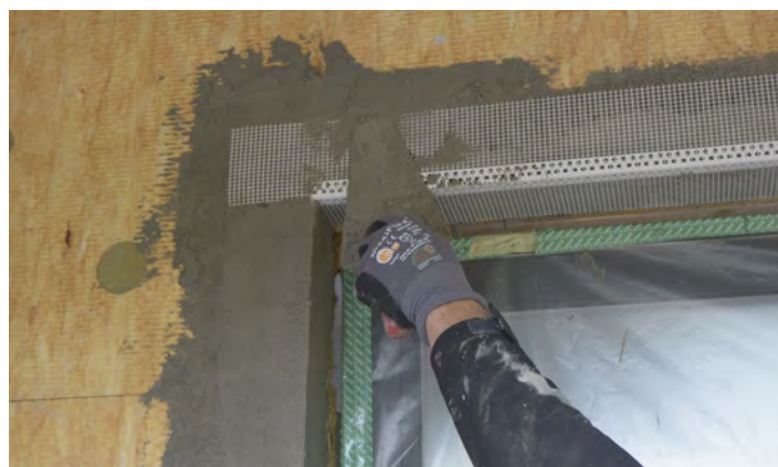
Montering af tilpasset hjørneliste i vinduesoverfals
