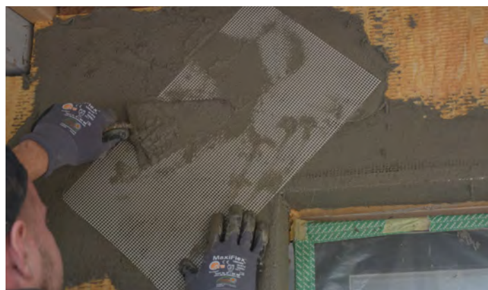
Ekstra forstærkning med stykker af armeringsnet
