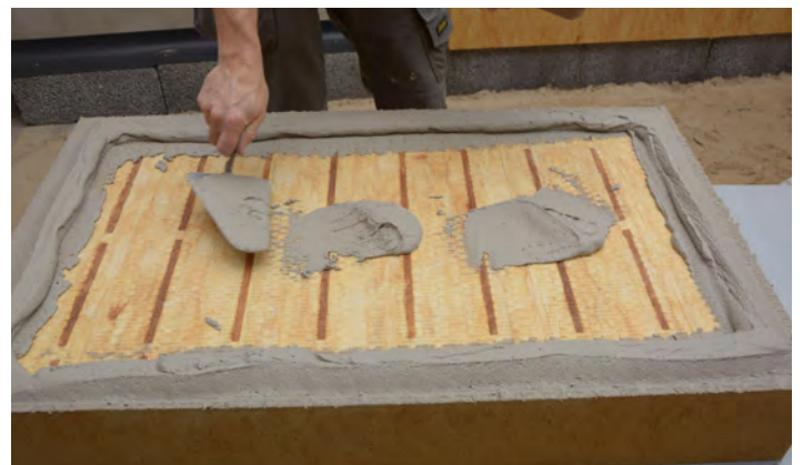
Påføring af facadeklæber med spandske
