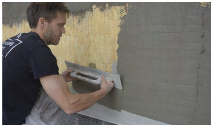
Påføring af grundpuds - Alfix DuraPuds 810
