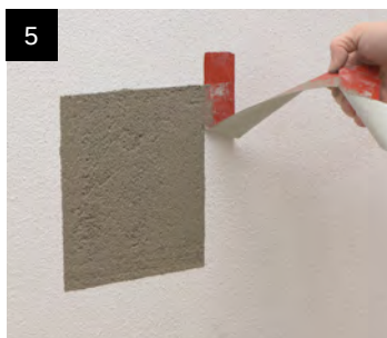
Afdækningstape fjernes
