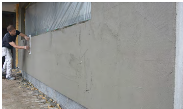
Efterglit med stålbræt
