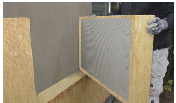
Montering på jævnt underlag
