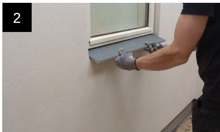
Montering af skifer-inddækning
