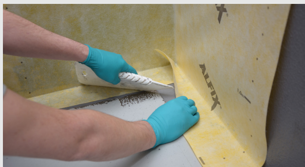
Metode 2: Montering af banemembranen
