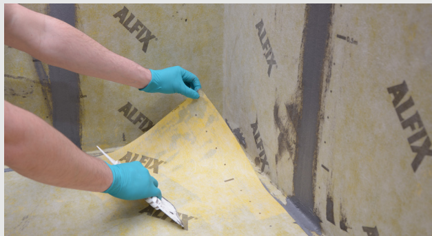
Montering af banemembran på gulv
