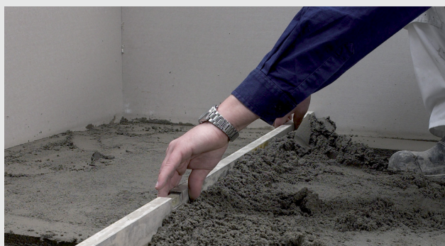
Støbning på træbjælkelag
