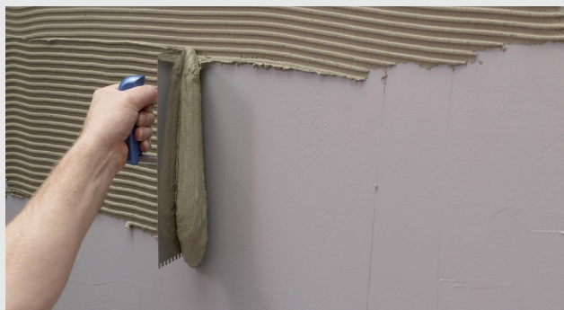
Påføring af fliseklæber
