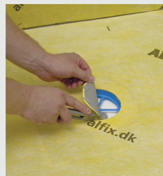
2: Udskæring med skabelon ved afløbsmanchet Type H
