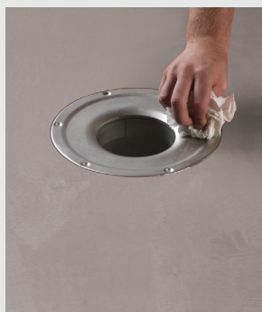
Rengøring af afløbets flange
