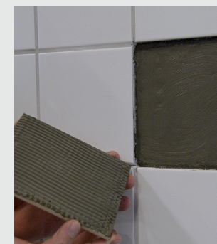
Tætningsmassen påføres underlaget, og flisen monteres
