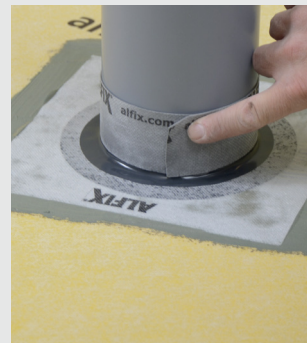
Forstærkning med Seal-Strip ved vandbelastede rør
