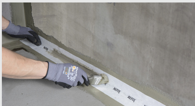
Metode 1: Montering af Alfix VT-Tætningsbånd
