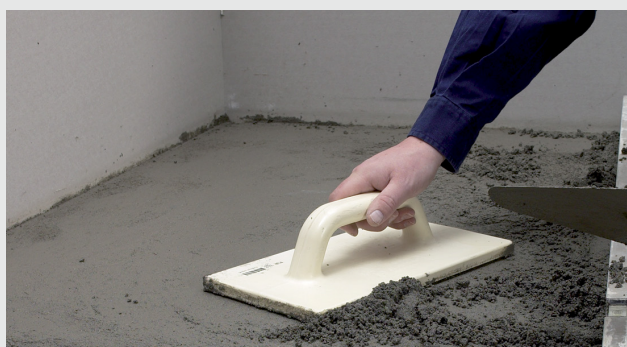
Udglatning med fugebræt
