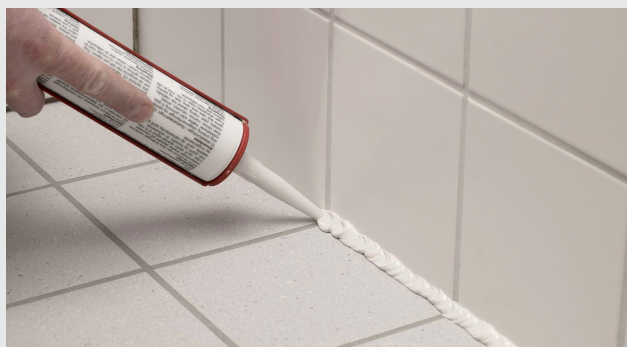
Fyldning med siliconebaseret fugemasse
