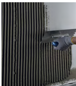
Påføring af Alfix DuraPuds 710 / 810 med tandspartel
