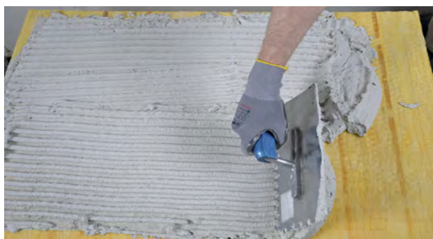
Påføring af Alfix DuraPuds 830 med tandspartel
