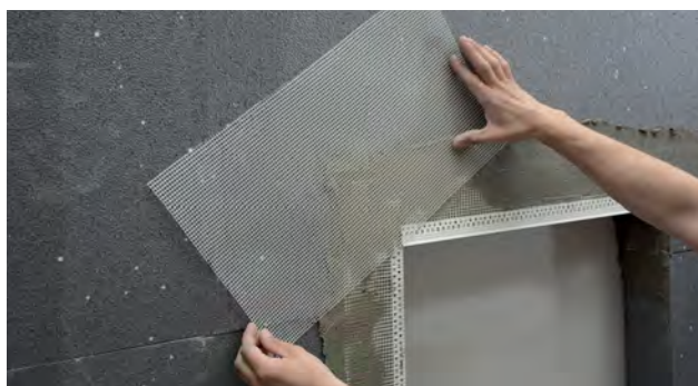
Tilpasning af armeringsnet ved vinduesfals
