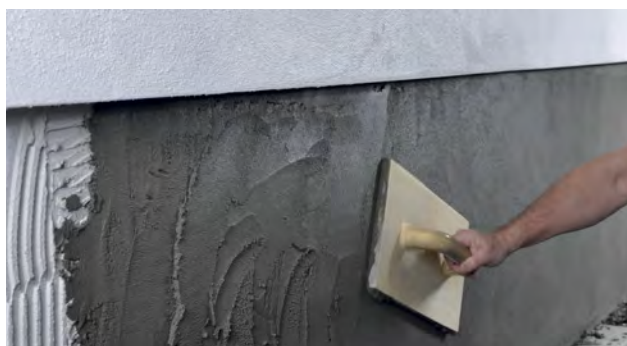
Pudsning af sokkel med pudsebræt
