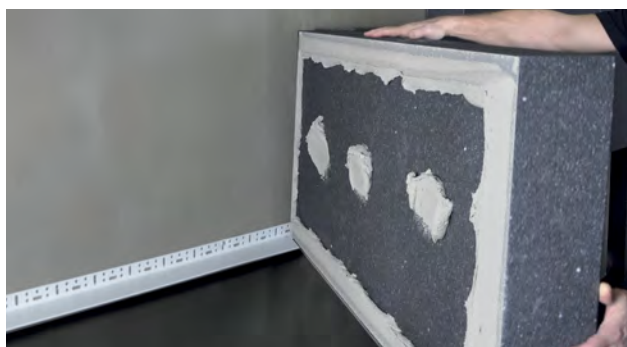
Montering af isoleringsplade
