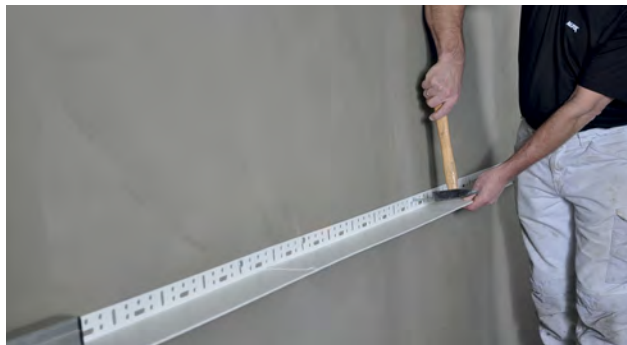
Montering af Alfix Startvinkel Flex
