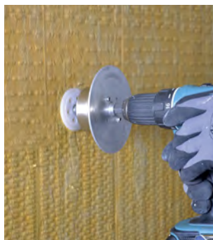
Montering af dybler og isætning af rondel
