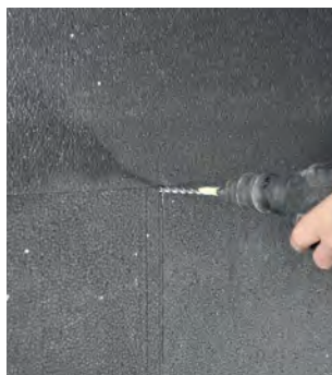
Montering af termodybel
