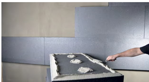
Påføring af Alfix DuraPuds 830 med reparations ske
