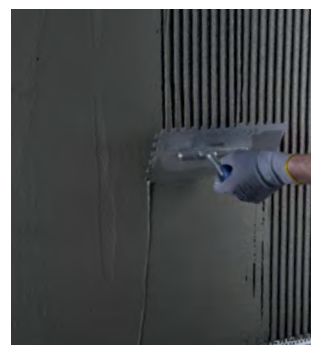
Påføring af Alfix DuraPuds 710 / 810 med tandspartel
