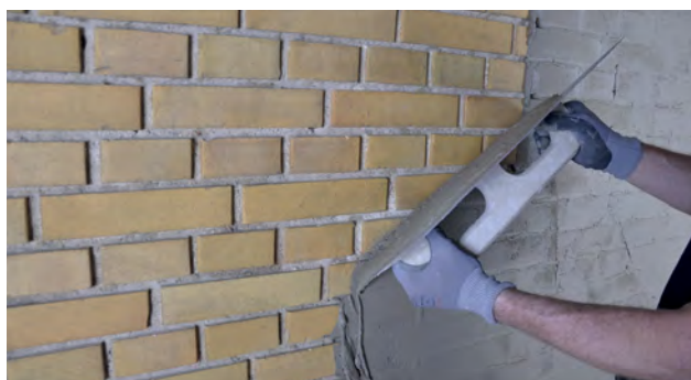
Påføring af kontaktlag med DuraPuds 710
