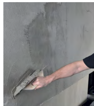
Montering af net med min. 10 cm overlap og påføring af heldækkende lag Alfix DuraPuds 810
