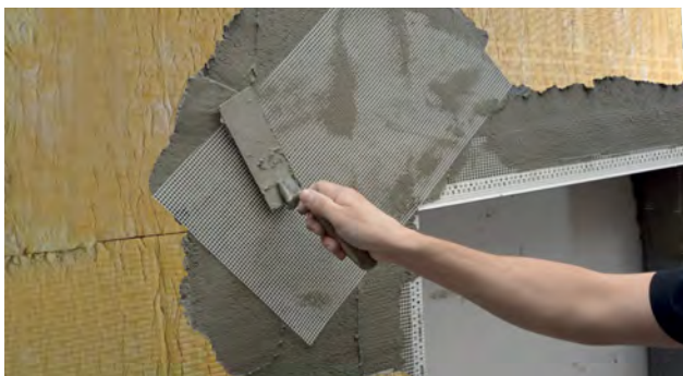
Montering af armeringsnet ved vinduesfals
