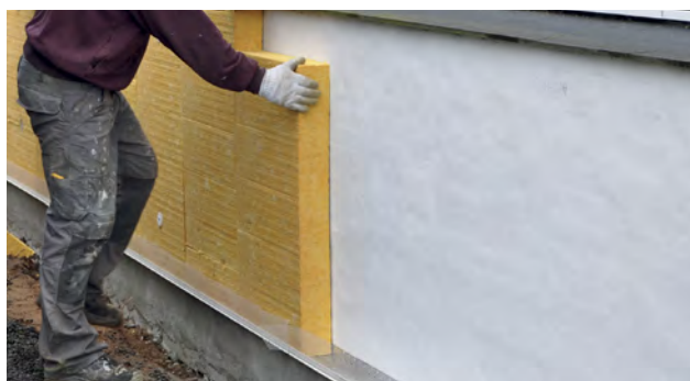
Montering af mineraluldsplader min. 15 cm over terræn
