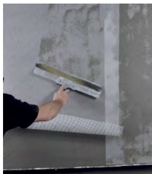
Montering af net med min. 10 cm overlap og påføring af heldækkende lag Alfix DuraPuds 810
