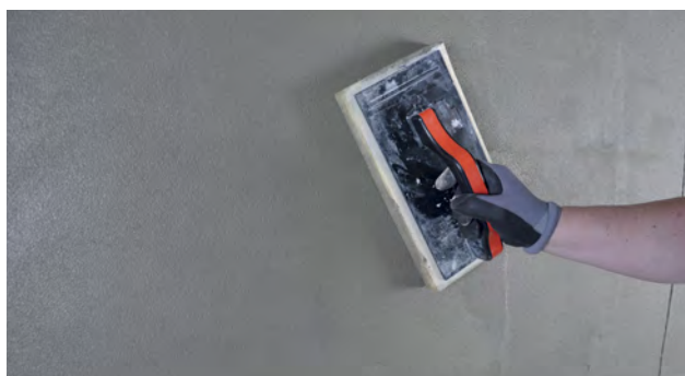
Filtsning af overfladen
