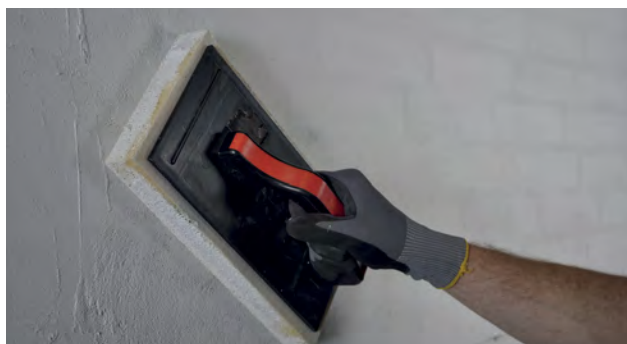
Filtsning af overfladen
