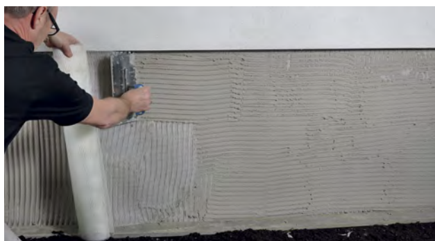
Montering af armeringsnet i Alfix DuraPuds 615
