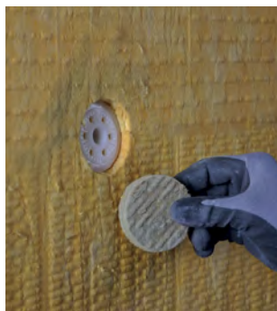
Montering af dybler og isætning af rondel
