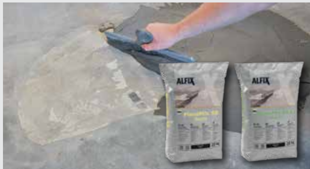
Revner og lunger udbedres
