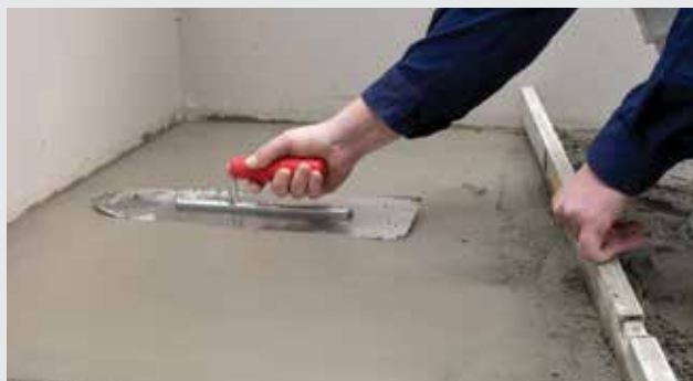
Støbemasse glattes ud med spartel
