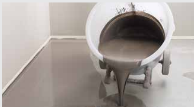
Udhældning af spartelmasse
