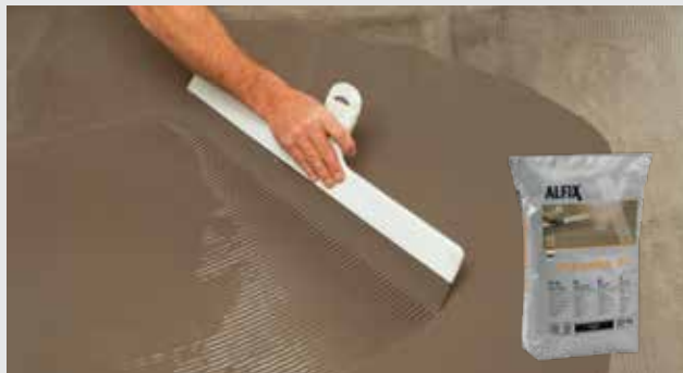
Fordeling af spartelmasse
