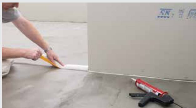
Afgrænsning med selvklæbende spartelstop
