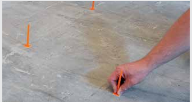
Markering med kotemål
