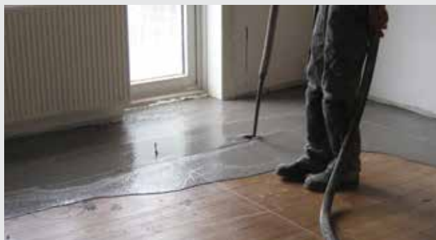
Spartling på træbjælkelag
