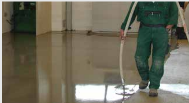
Udlægning med spartelpumpe
