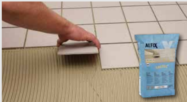
Flisemontering i Alfix fliseklæber
