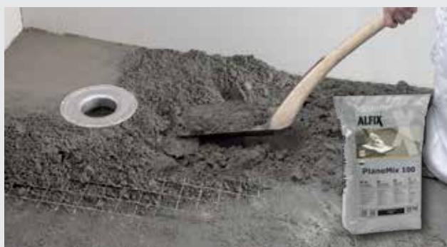
Opbygning af fald med støbemasse
