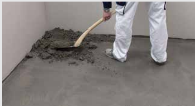
Støbemasse fordeles jævnt
