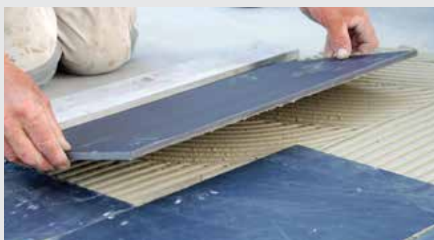
Montering af fliser
