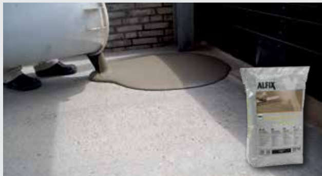
Udhældning af selvudflydende spartelmasse
