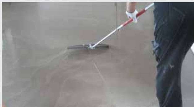
Fordeling af spartelmassen
