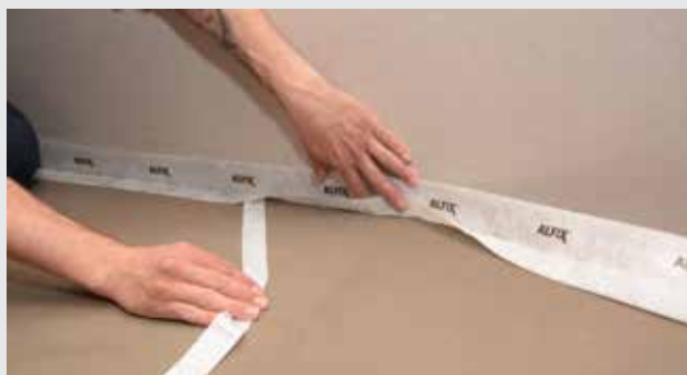
Montering af selvklæbende vægkantbånd
