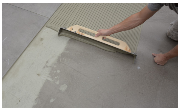
Fliseklæber trækkes på underlaget
