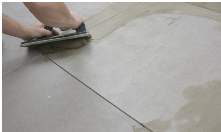
Påføring af fugemasse
