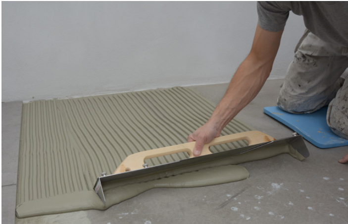
Påføring af fliseklæber på underlaget
