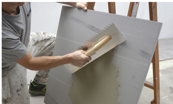
Påføring af fliseklæber på flisens bagside
