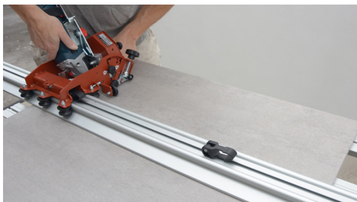
Skæring af flise efter styreskinne
