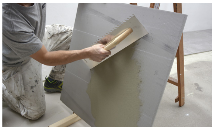
Fliseklæber påføres bagsiden af flisen (bagsmøring)
