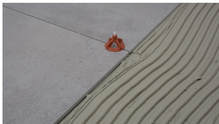
Eksempel på nivelleringsystem til fliser
