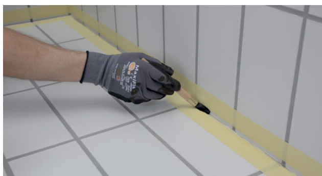
Etter montering av maskeringstape, påføres Alfix P-Primer
