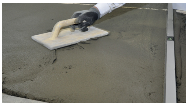
Bearbeiding med pussebrett
