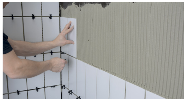
Montering av fliser
