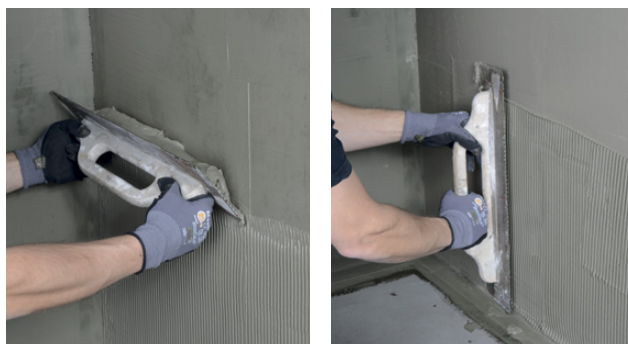
Påføring av 2K Tetningsmasse og glatting
