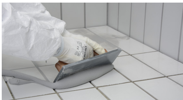
Påføring på gulv med epoxyfugebrett
