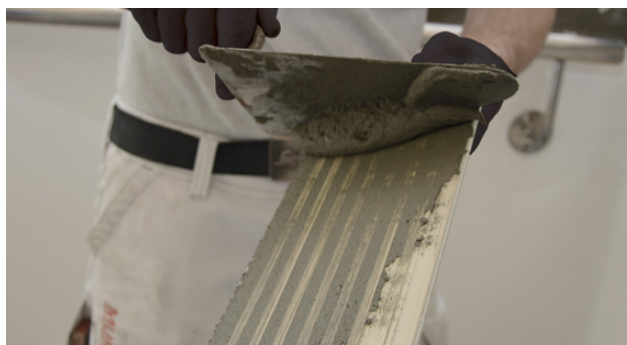
Påføring av skrapelag på baksiden av flisen
