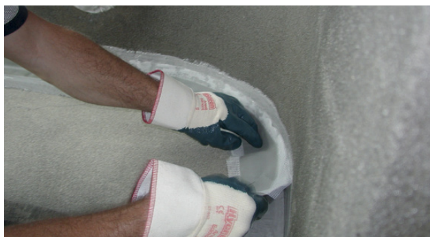
Montering av Alfix Tetningsbånd
