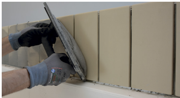
Påføring av Alfix CeraFill 18 resistant
