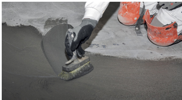
Legging av grunningslag
