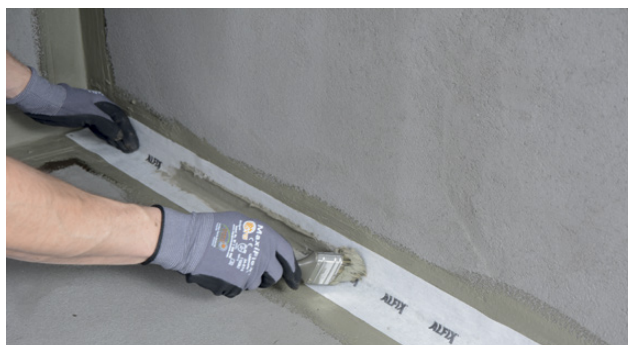
Montering av Alfix VT-tetningsbånd
