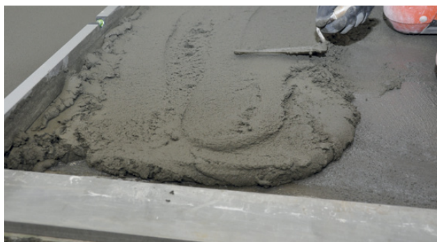
Utlekking og komprimering på gulv Alfix PlaneMix S40
