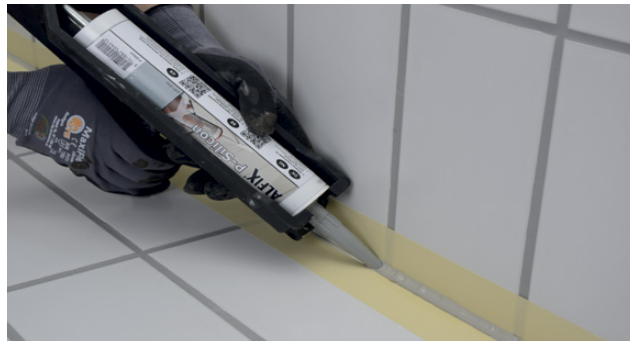
Når primeren er tørr, fylles fugene med Alfix M-Silicon
