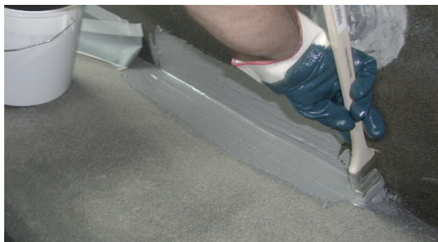
Påføring av Alfix Epoxy Membran
