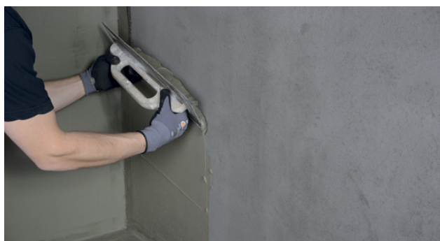
Påføring av Alfix 2K Tetningsmasse – porefyllende lag
