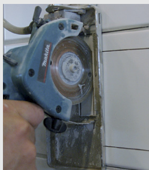
Skjær et spor langs flisekantene. Fjern flisen forsiktig
