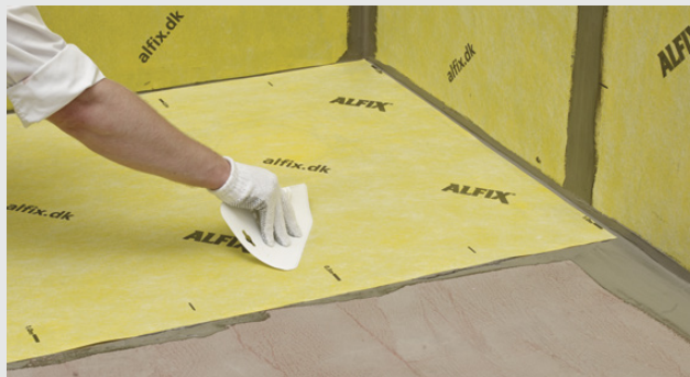
Montering av folie på gulv
