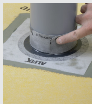
Forsterkning med Seal-Strip ved vannbelastete rør
