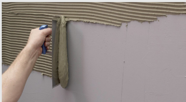
Påføring av flislim
