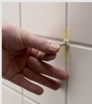
Montering av ekspansjonsplugg og montering av skrue
