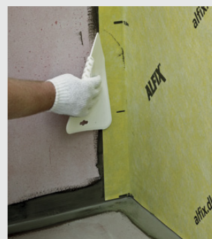
Montering av folie i hjørne
