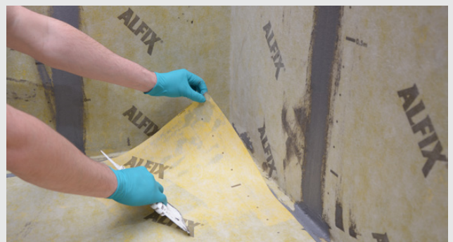
Montering av banemembran på gulv
