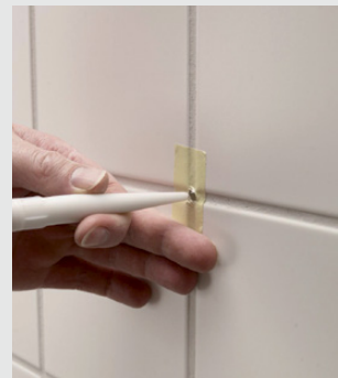
Bor et hull og fyll det med Alfix M-Silicon
