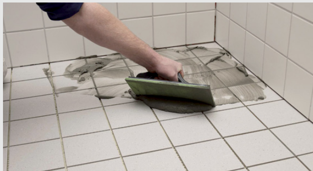
Påføring av sementbasert fugemasse
