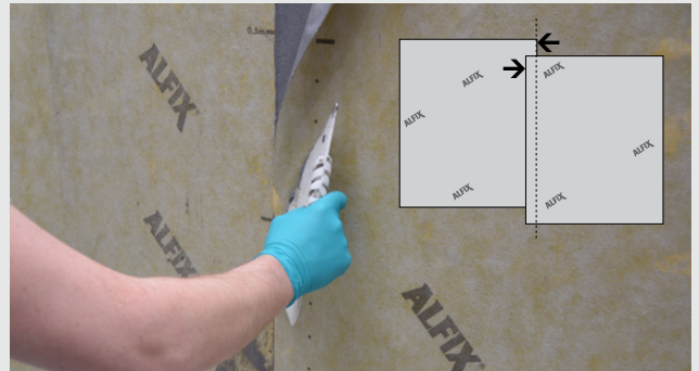
Montering av banemembran med hjørneskjøte
