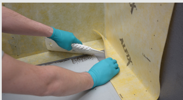
Montering av banemembranen
