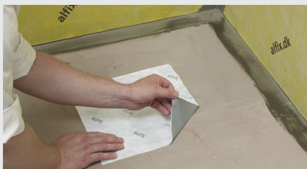
Montering av Alfix slukmansjett
