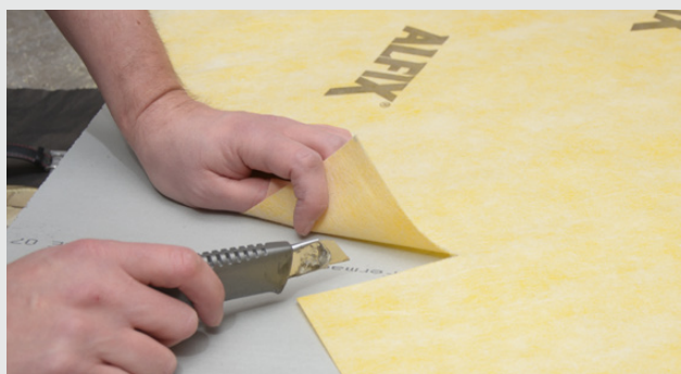
Kutt 100 mm. i vegg-/veggvinkelen der banemembranen monteres rundt hjørnet
