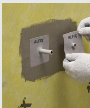
Montering av VT-rørmansjetter
