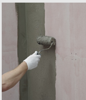
Påføring av tetningsmasse
