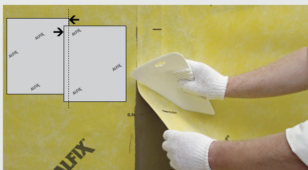
Montering av folie ved skjøter
