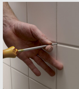
Montering av ekspansjonsplugg og montering av skrue
