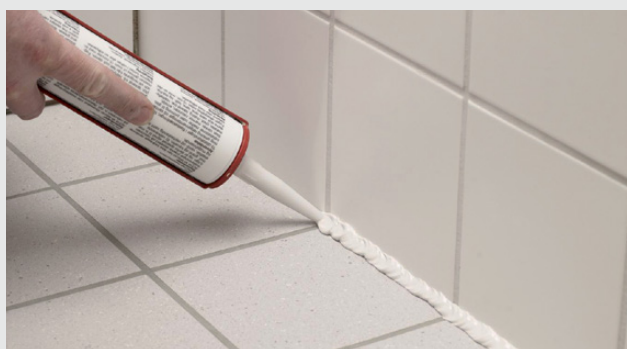
Fylling med silikonbasert fugemasse
