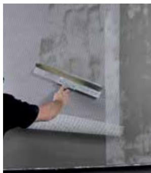
Montering av nett med minst 10 cm overlapping og påføring av et heldekkende lag med Alfix DuraPuds 810
