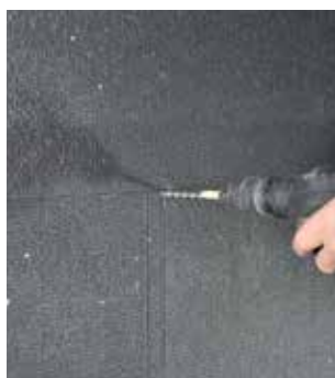
Montering av termodybel
