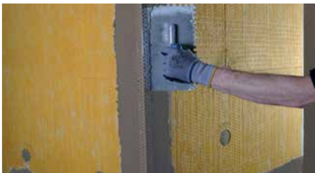
Montering av hjørnelister
