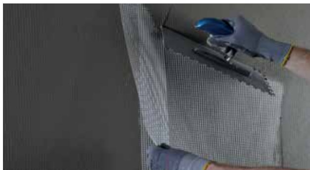
Montering av nett med minst 10 cm overlapping
