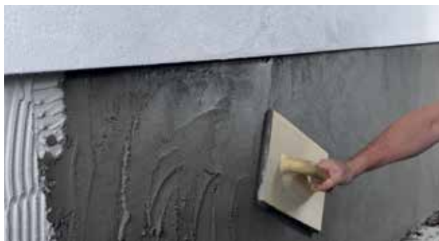
Pussing av sokkel med pussebrett
