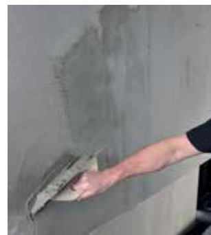
Montering av nett med minst 10 cm overlapping og påføring av et heldekkende lag med Alfix DuraPuds 810
