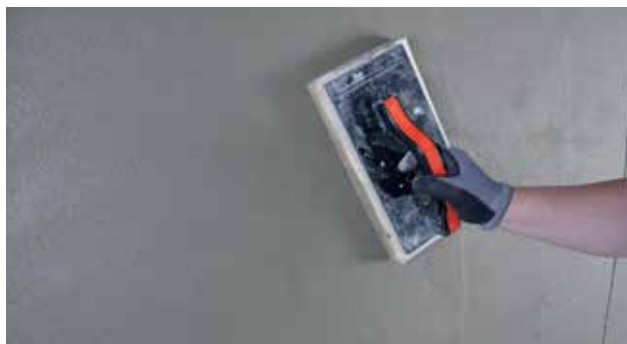
Filsing av overflaten
