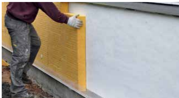
Montering av mineralullplater min. 15 cm over terrenget
