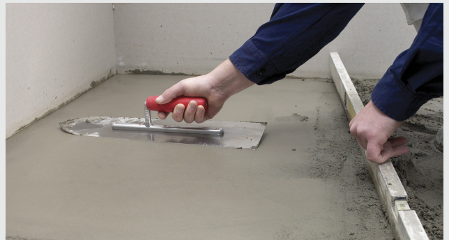
Støpemasse glattes ut med sparkel
