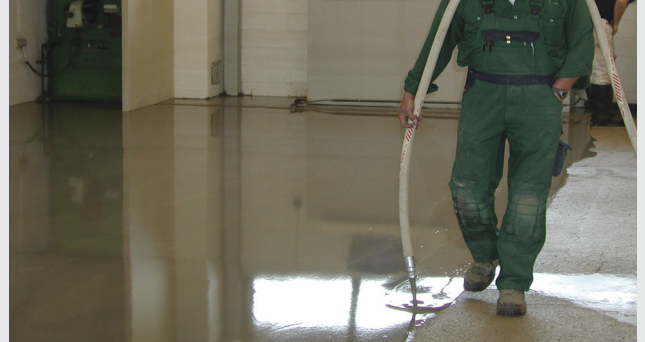
Utlekking med sparkelpumpe
