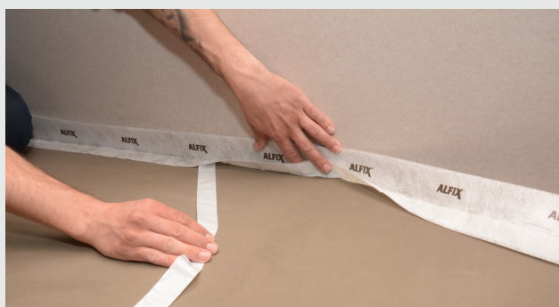
Montering av selvklebende veggkantbånd
