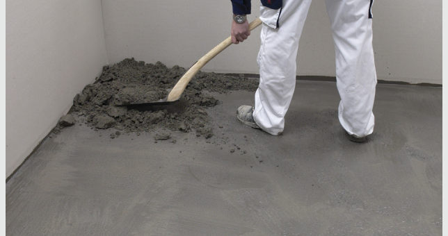
Støpemasse fordeles jevnt
