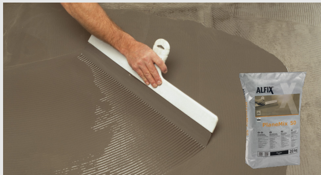
Fordeling av sparkelmasse
