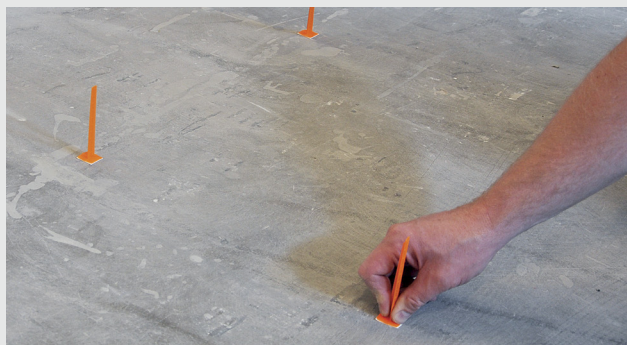
Markering med kotemål
