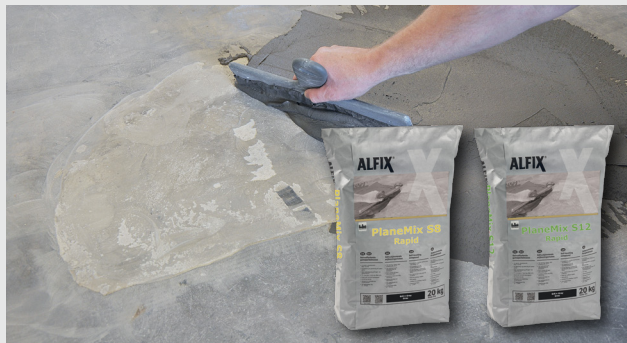
Sprekker og hulrom utbedres
