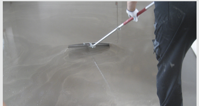
Fordeling av sparkelmassen
