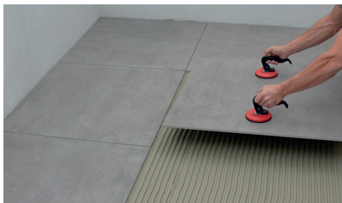
Montering av flise med sugekopper
