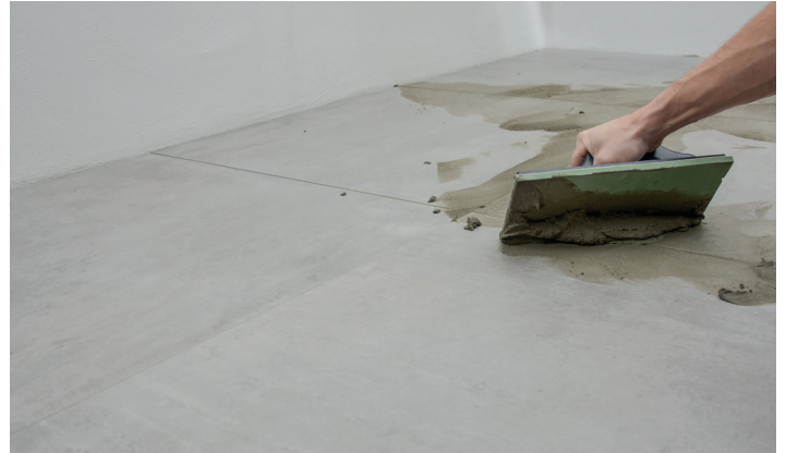
Påføring av fugemasse
