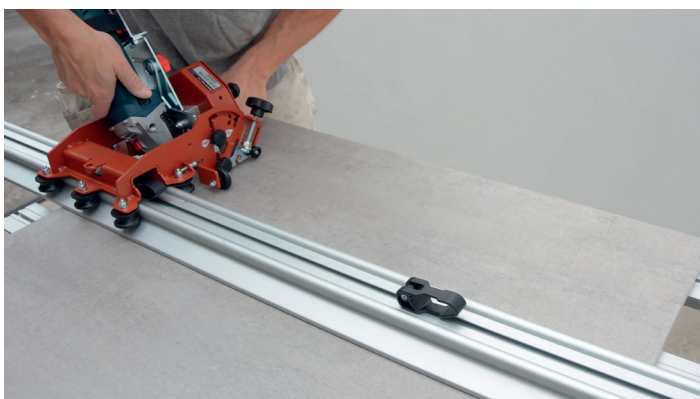
Skjæring av flise etter styreskinne
