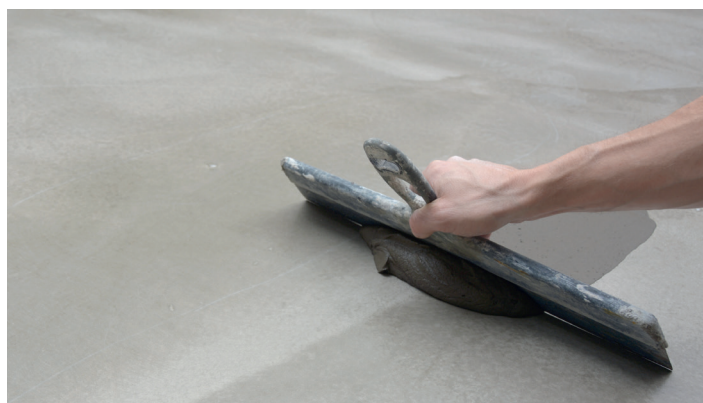
Opretting av ujevnheter
