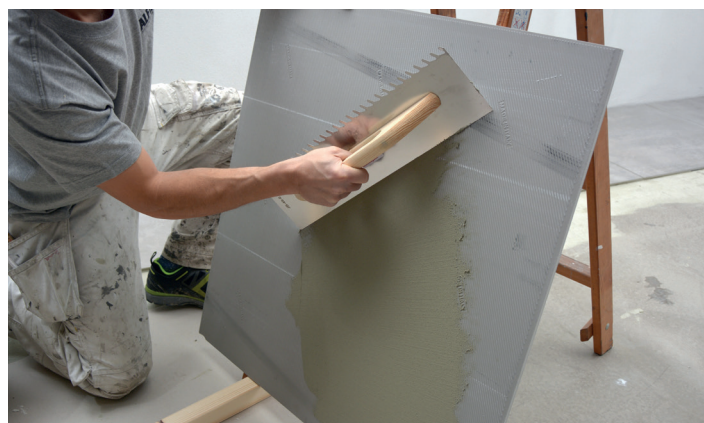
Flislimet påføres baksiden av flisen (baksmøring)
