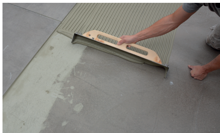
Flislim trekkes på underlaget
