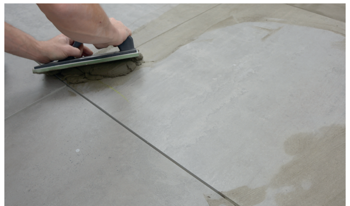
Påføring av fugemasse
