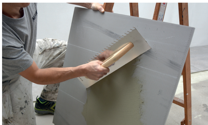
Påføring av flislim på flisens bakside
