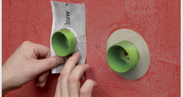
Montering ved rør
