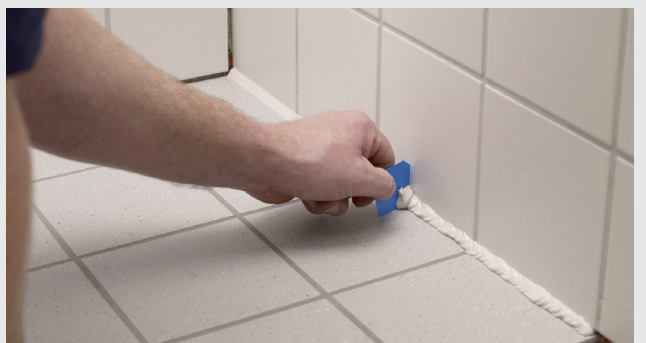
Overflødig fugemasse fjernes
