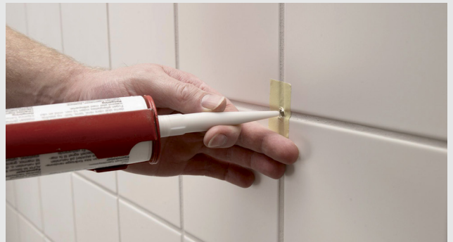
Fylling av hullet med silikon
