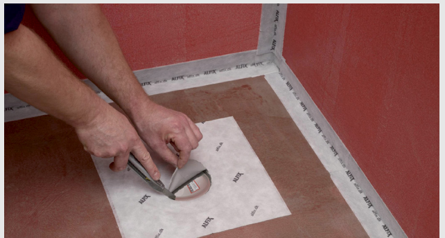
Markering og utskjæring av hull
