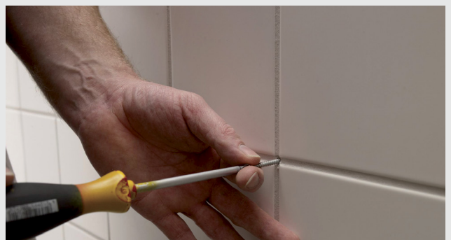
Montering av skrue etter fylling med silikon
