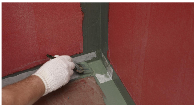
Montering av VT-tetningsbånd og hjørner i teningsmasse
