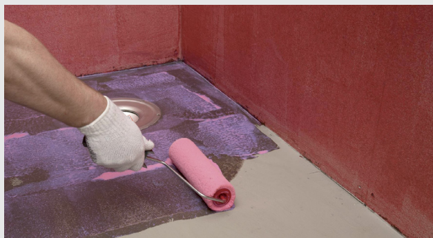
Priming av gulv med rulle
