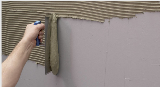
Påføring av flislim
