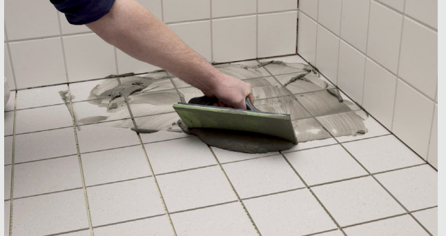
Påføring av sementbasert fugemasse
