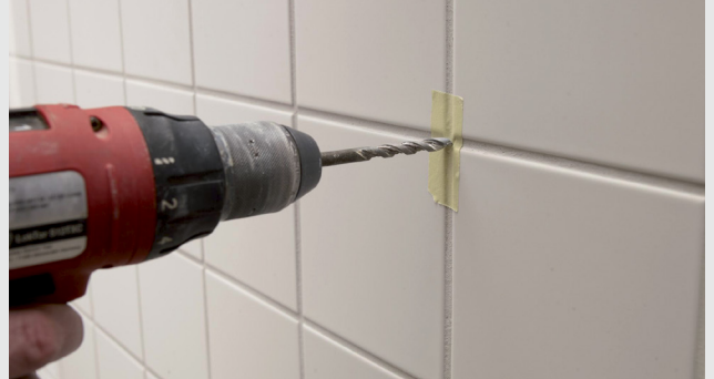
Boring av hull
