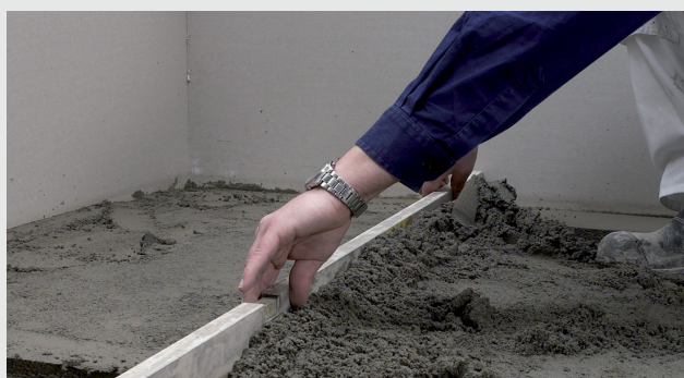
Utsøping på trebjelkelag
