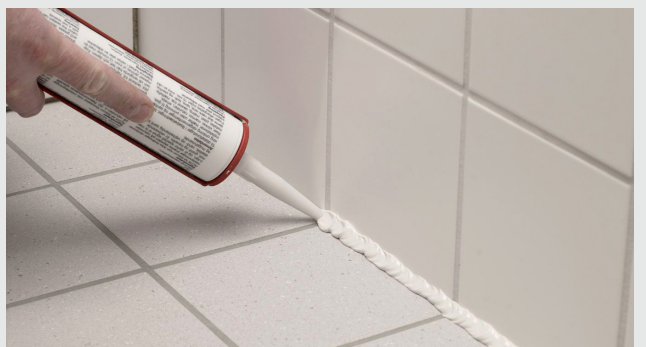
Fylling med silikonbasert fugemasse
