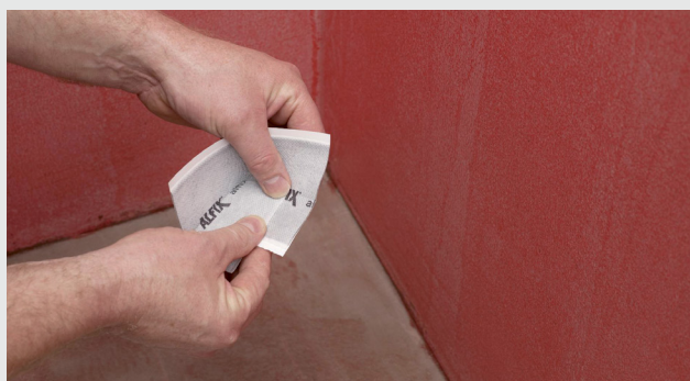
Tilpassing av selvklebende hjørne
