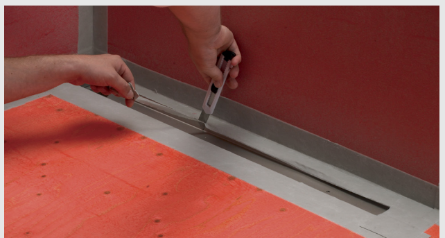
Renskjæring av kanter ved design avløp
