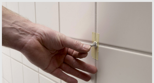
Montering av ekspansjonsplugg
