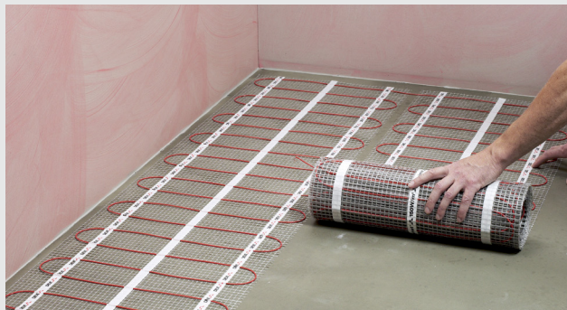
Utlegging av varmematter
