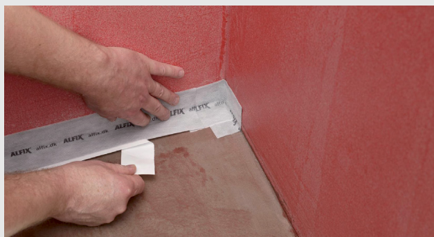
Montering i overgang mellom vegg og gulv
