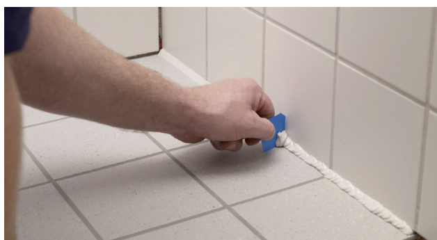
Överskjutande Alfix Silicon skrapas bort
