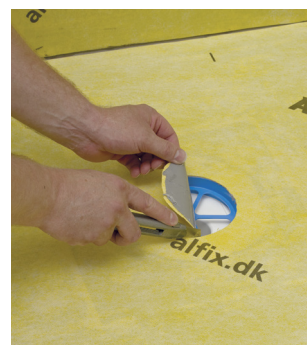
Alt. 2: Utskarning med skärmall vid manschett
