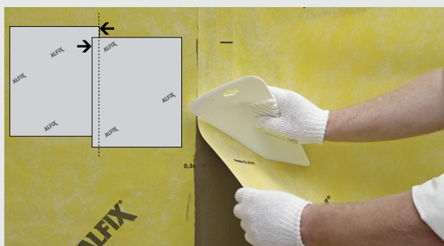
Montering av våd omlott vid skarvar
