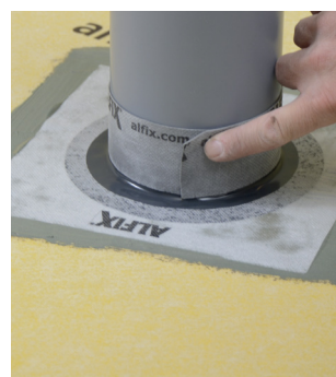
Ev. förstärkning med Seal-Strip, där röret utsätts för vattenbelastning.
