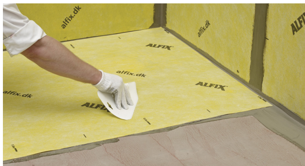
Montering av våd på golv
