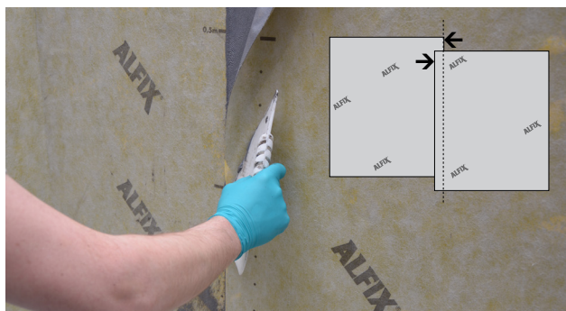
Montering av våd omlott vid skarv
