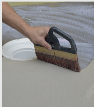
Reglering av sugförmåga Försegling med VT-hörn/-remсор
