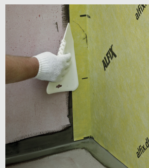
Påföring av tätningsmassa Montering av våd i hörn
