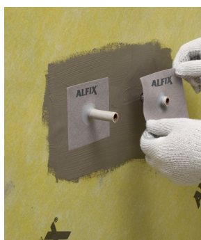
Montering av VT-Rörmanschetter
