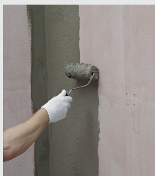
Påföring av tätningsmassa Montering av våd i hörn
