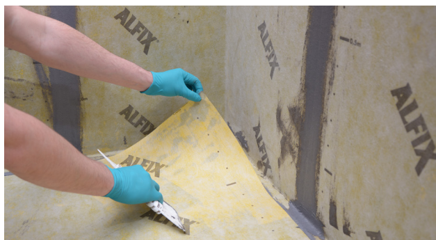
Montering av våtrumsmatta på golv
