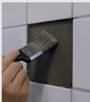
Tätningsmassan påförs underlaget och plattan monteras
