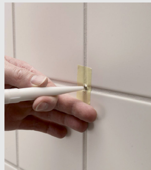
Borra ett hål och fyll hålet med M-Silicon
