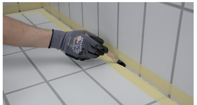
Efter fastklistring av maskeringstejp påförs primer
