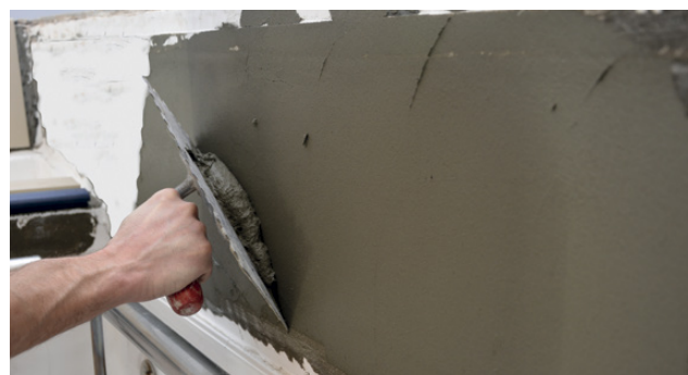
Applicering av kontaktskikt
