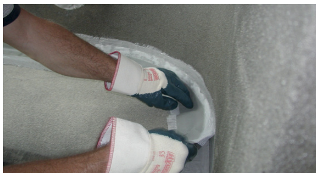
Montering av Alfix Tättningsband
