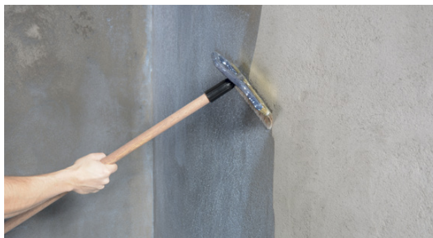
Primerbehandling med Alfix PlaneMixPrime
