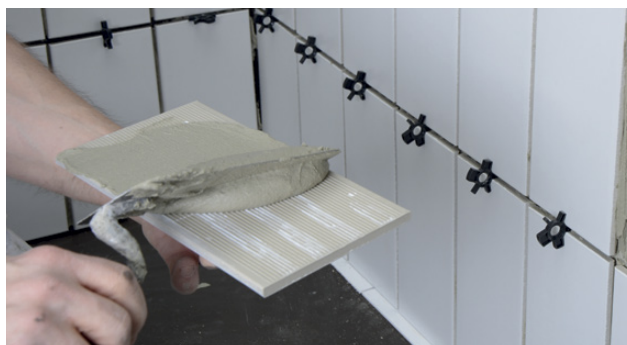
Dubbellimning (buttering/floating metoden)
