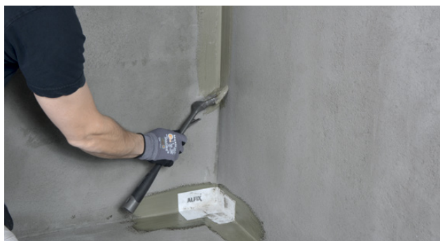
Montering av Alfix VT-hörn i tätningsmassa
