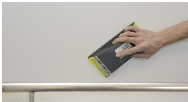
Grovslipning av PVC-liners
