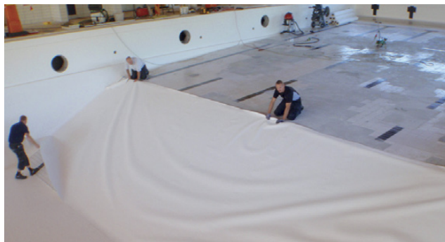
Montering av PVC-liners
