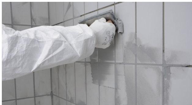
Ifyllning på vägg med epoxifogbräda
