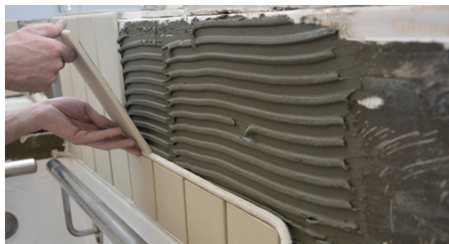
Montering av plattor
