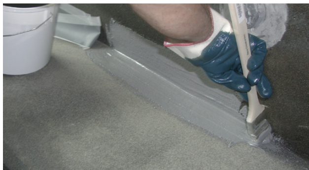
Applicering av Alfix Epoxy Membran
