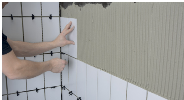
Montering av plattor
