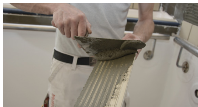
Applicering av kontaktskikt på plattornas baksida
