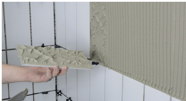
Kontroll av fästmassans täckning
