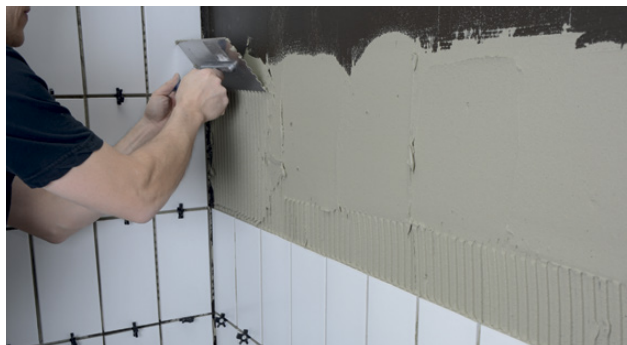
Applicering av fästmassa med tandspackel
