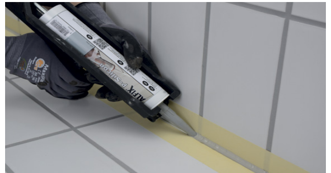
När primern är torr fylls fogarna med Alfix M-Silicon
