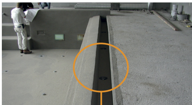
Montering av Alfix Tättningsband
