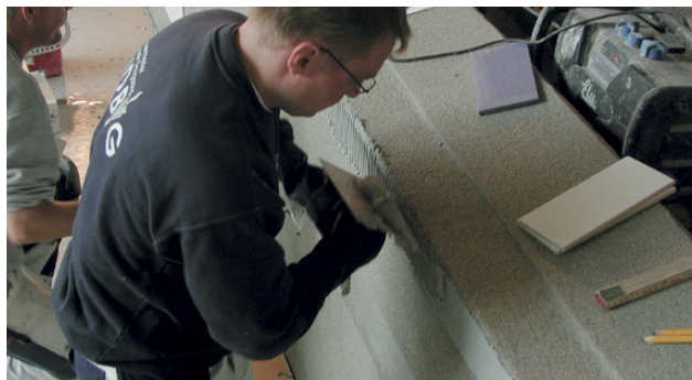
Applicering av Alfix C2 Epoxy med tandspackel
