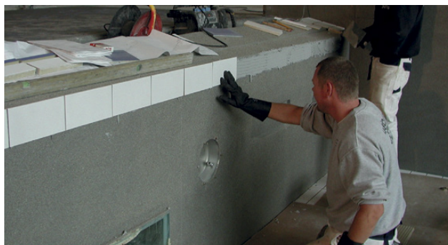
Montering av plattor i den fuktiga fästmassa
