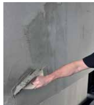
Montering av nät med minst 10 cm överlappning och påföring av heltäckande skikt Alfex DuraPuds 810
