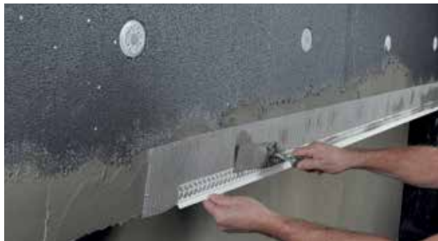
Montering av Alfex Bottenlist Flex
