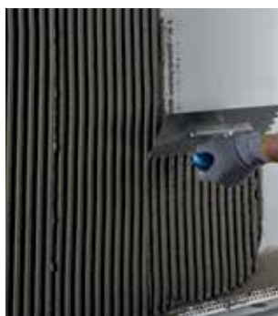
Påföring av DuraPuds 710/810 med tandspackel
