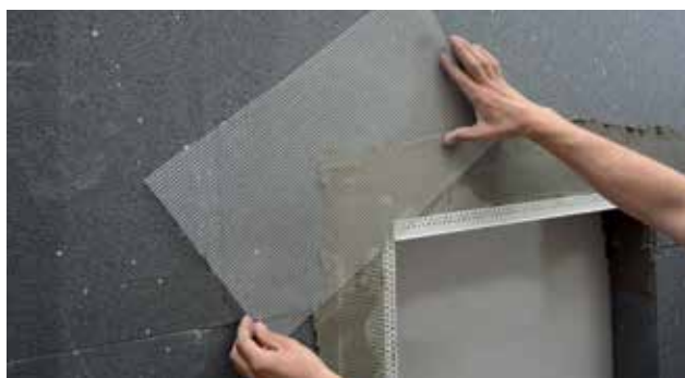
Inpassning av armeringsnät vid fönster
