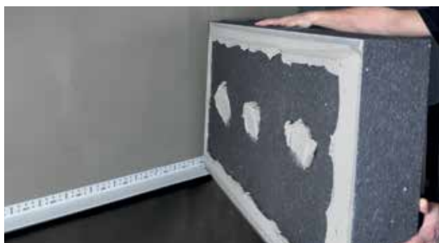
Montering av isoleringsskiva
