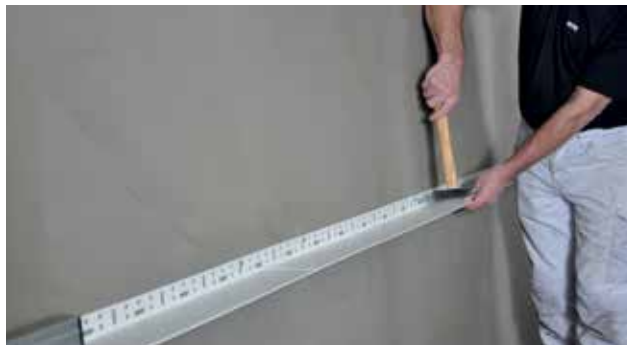
Montering av Alfix Startvinkel Flex
