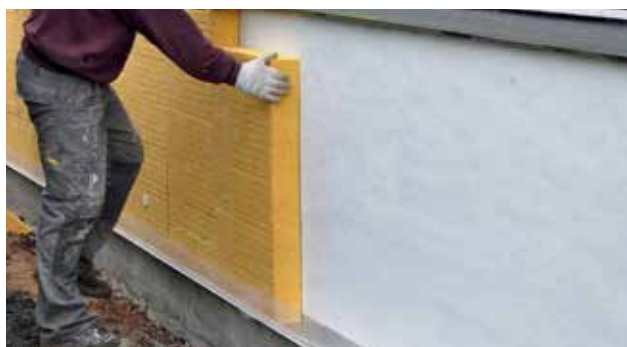
Montering av mineralullsskivor minst 15 cm över marken
