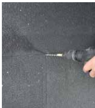
Montering af termoplugg
