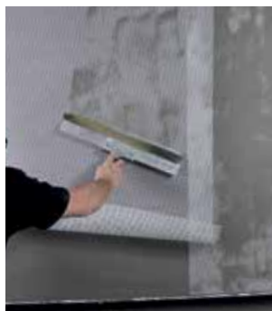
Montering av nät med minst 10 cm överlappning och påföring av heltäckande skikt Alfex DuraPuds 810
