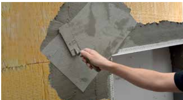
Montering av armeringsnät vid fönstersmyg
