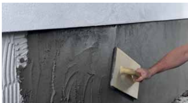
Putsning av sockel med putsbräda
