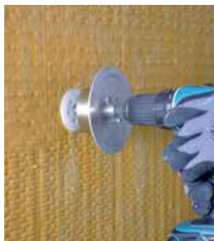
Montering av plugg och isättning av rondell
