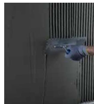
Påföring av DuraPuds 710/810 med tandspackel
