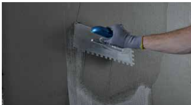
Glättning av nät med slätt stålspackel
