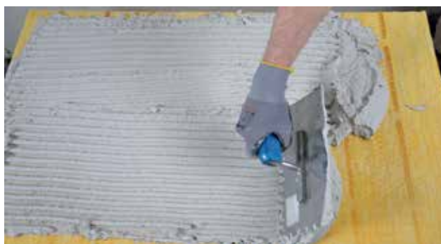
Påföring av DuraPuds 830 med tandspackel
