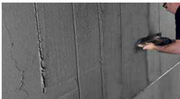
Påföring av DuraPuds 810 med stålbrätt med distanständer
