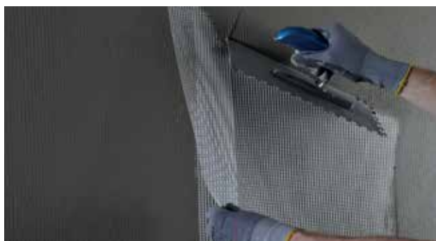
Montering av nät med minst 10 cm överlappning
