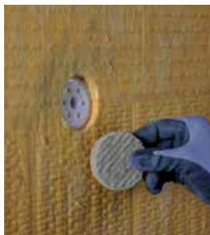
Montering av plugg och isättning av rondell
