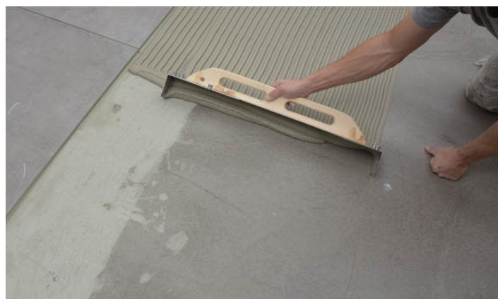
Applicering av fästmassa på underlag
