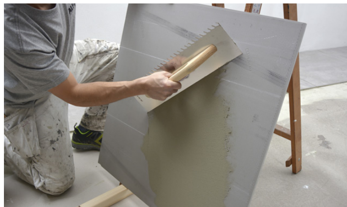
Applicering av fästmassa på plattans baksida (dubbellimning)
