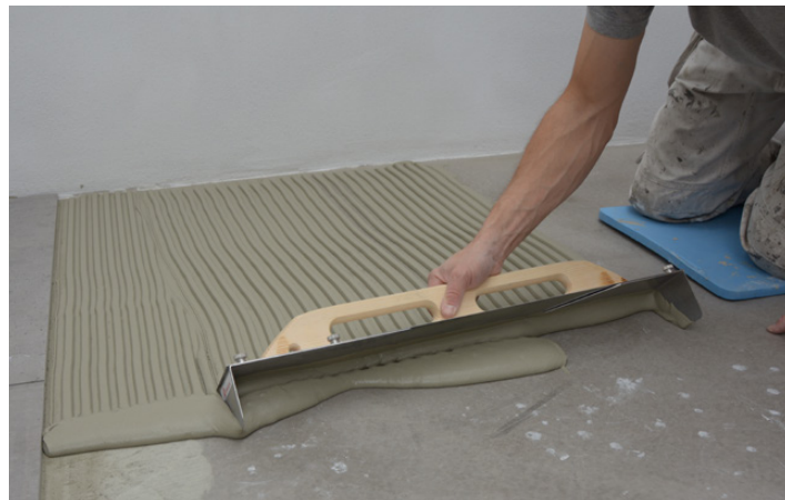
Applicering av fästmassa på underlaget
