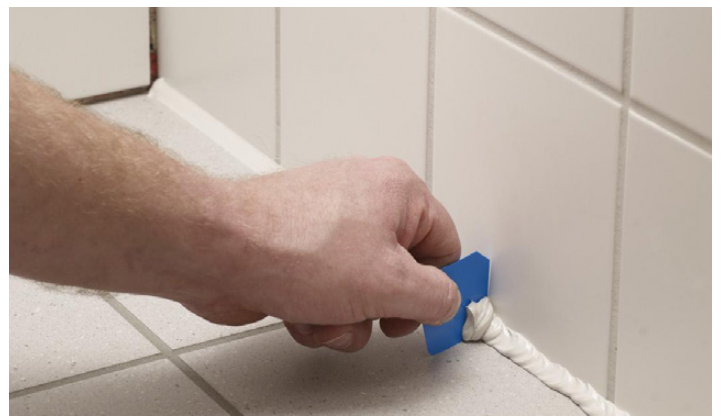
Överskjutande fogmassa skrapas bort
