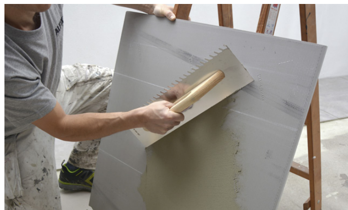
Applicering av fästmassa på plattans baksida (dubbellimning)
