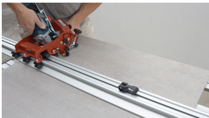
Skäring av plattor efter styreskinne
