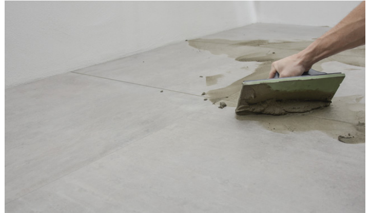
Påföring av fogmassa
