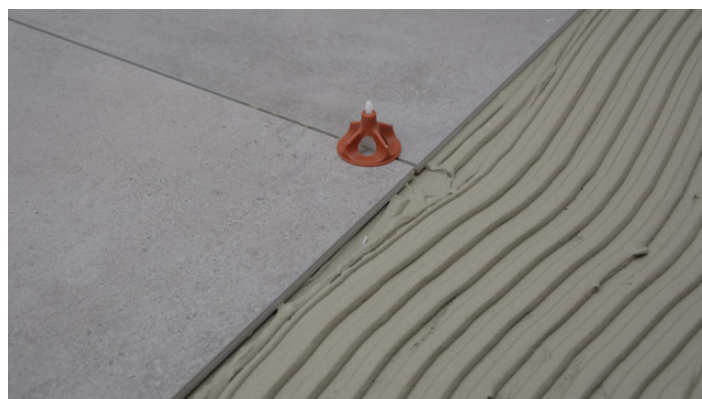
Exempel på nivelleringsystem för plattor
